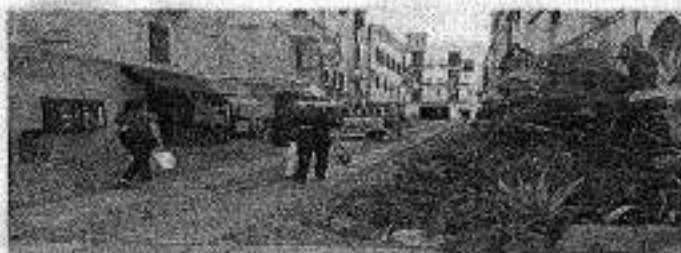
Una parte dei lavori di Abbano dove gli interventi in via Giovanni XXII di Sassari
